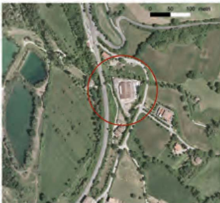
Stato di fatto - Confluenza del Rio Felisina e Rio Lazzara
